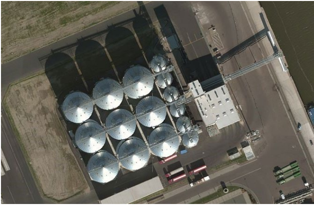
Abbildung 1: Großsilanlage der Firma Beiselen GmbH im Magdeburger Hafen. [BEI15]
