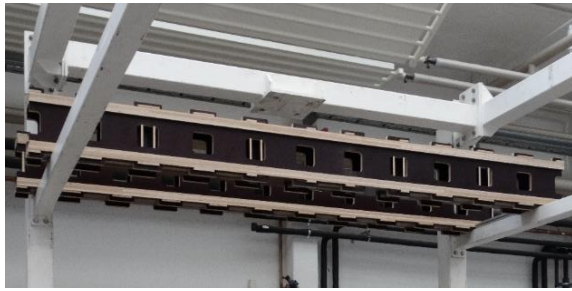
Abbildung 6: Montierter Zustand beider Kranbrücken
